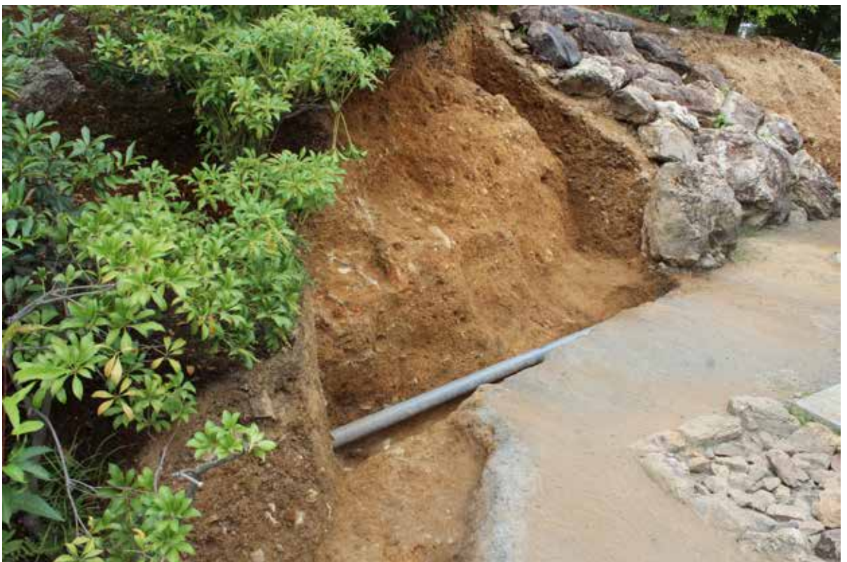
写真 20 第1 トレンチ b 区完掘状況 (南西から)
