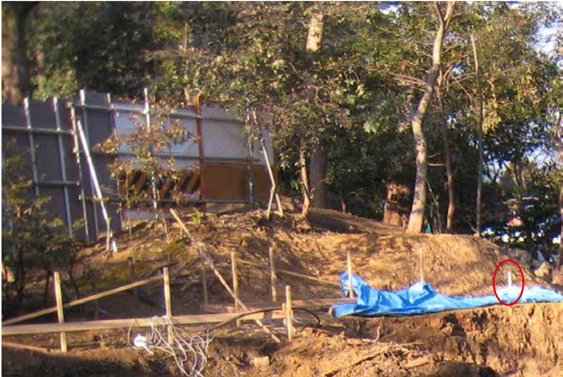
写真 12 第 1 トレンチ設定地点 (南西から・平成 26 (2014) 年 1 月 22 日撮影)
