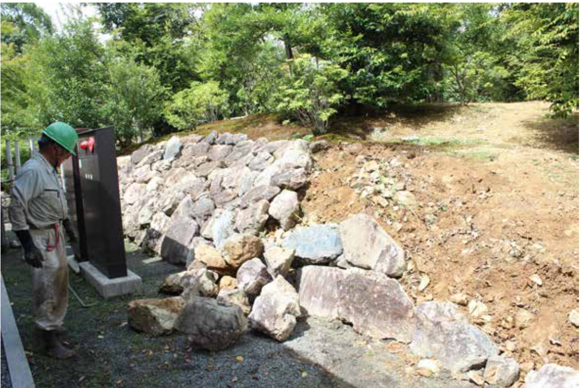
写真2 第1トレンチa区 貼石除去風景（東から・令和2（2020）年9月7日撮影）
