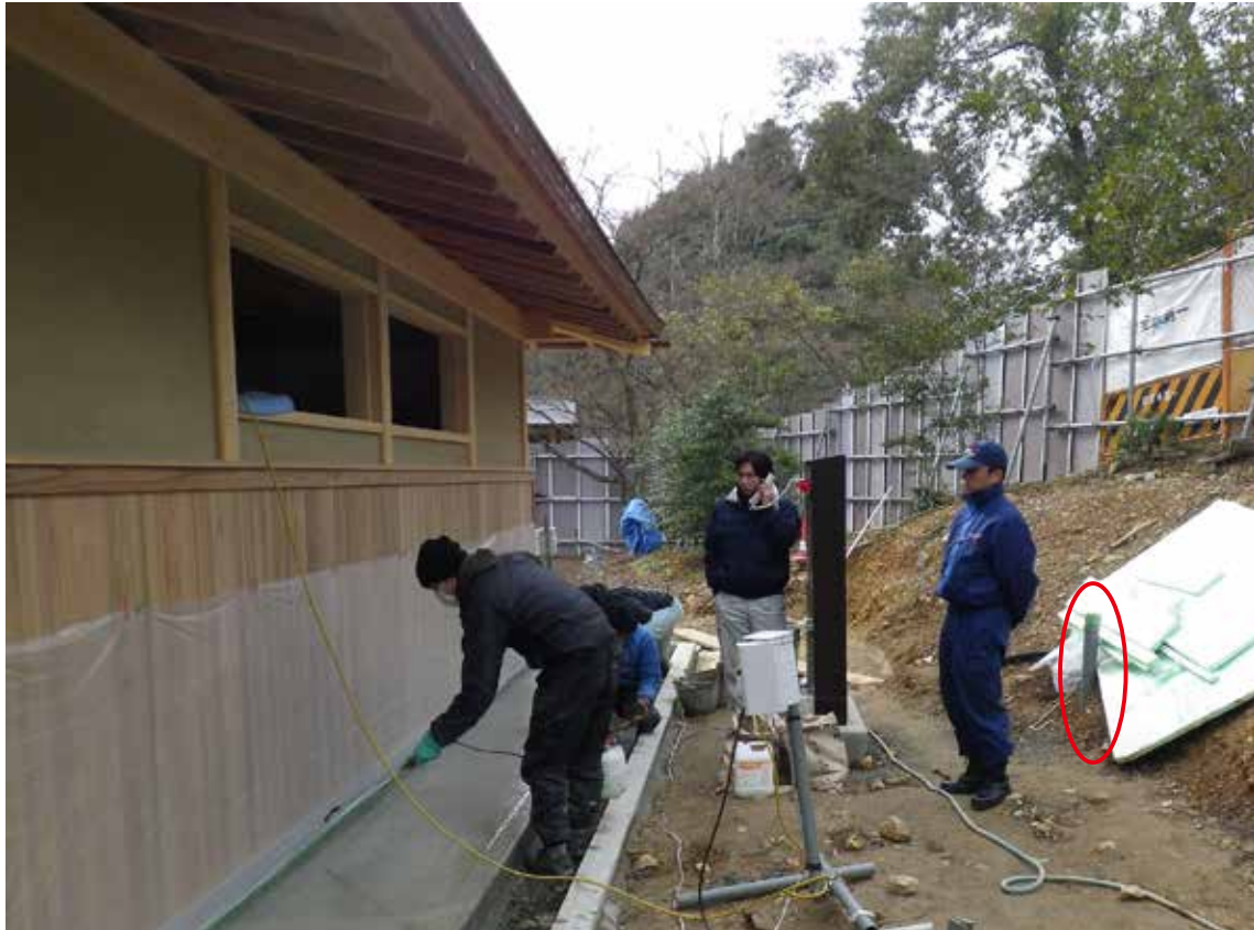
写真 13 第1トレンチ設定地点（東から・平成 27（2015）年1月30日撮影）
