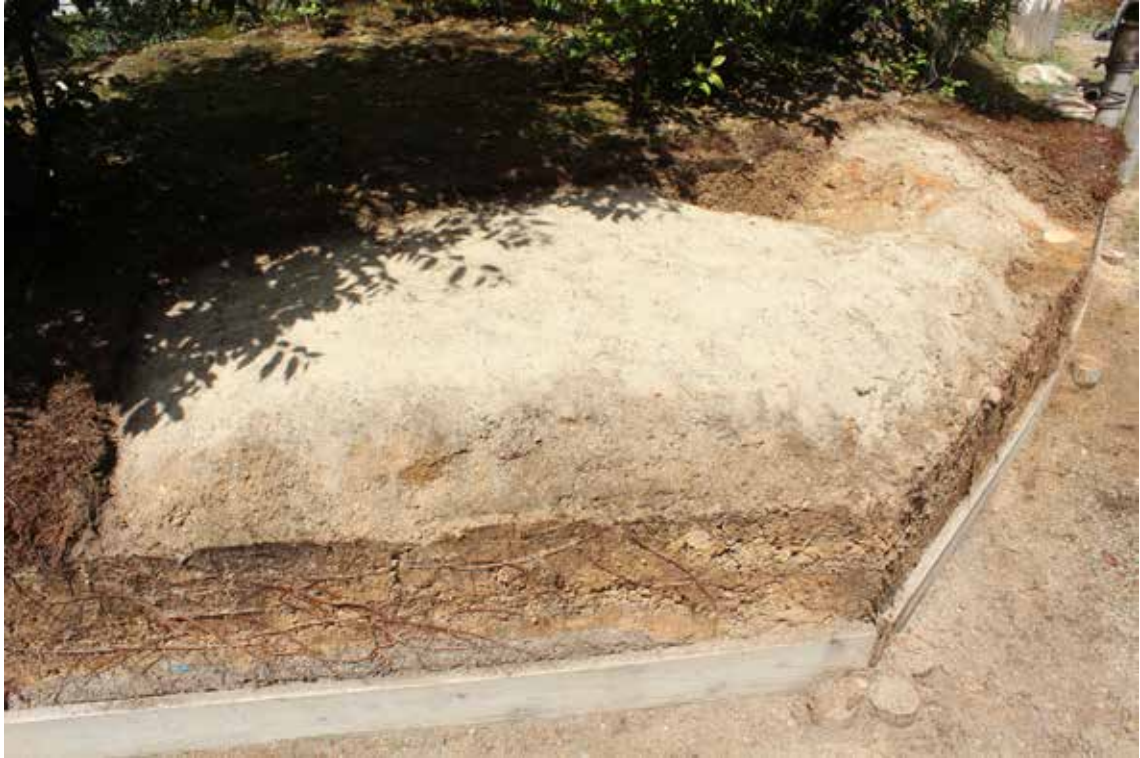
写真 15 第2トレンチ地点 苔シート・堰板除去状況（南東から・令和2（2020）年9月14日撮影）
