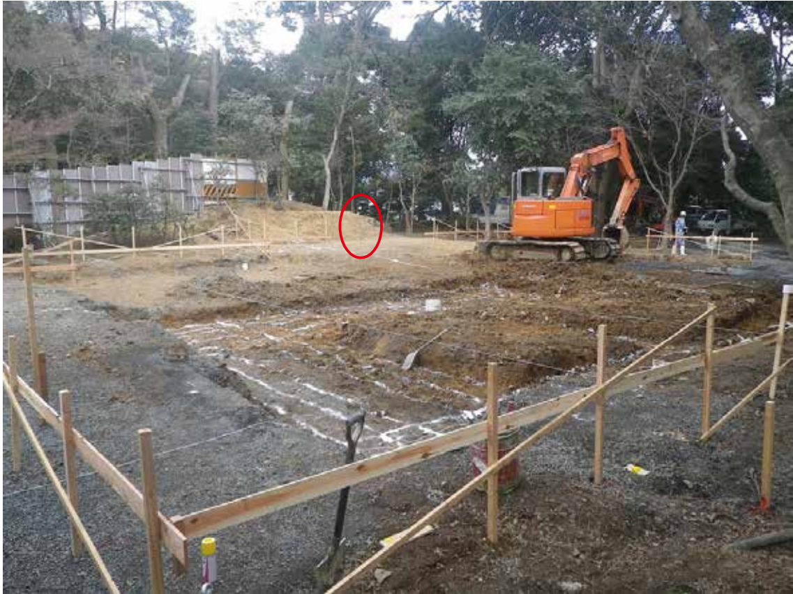
写真 11 第 1 トレンチ設置地点 (南西から・平成 26 (2014) 年 1 月 16 日撮影)
