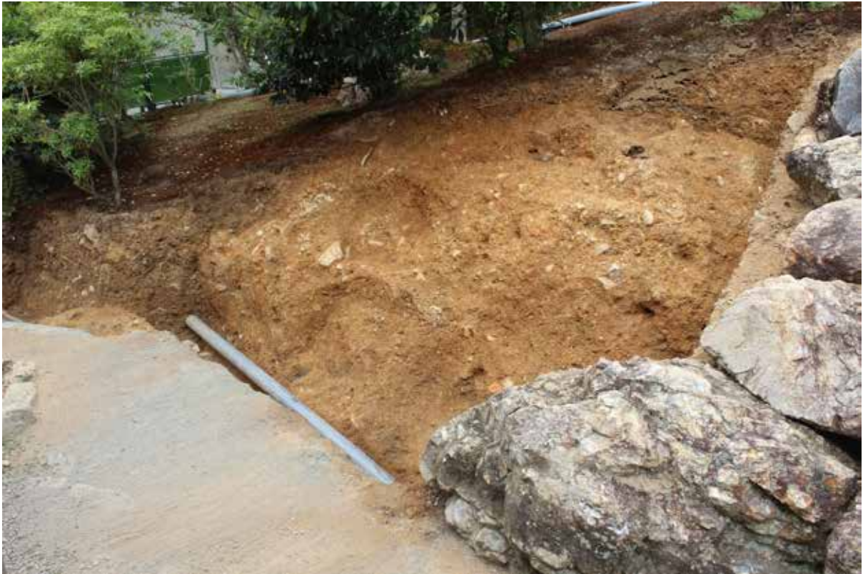
写真 19 第1 トレンチ b 区完掘状況 (南東から)
